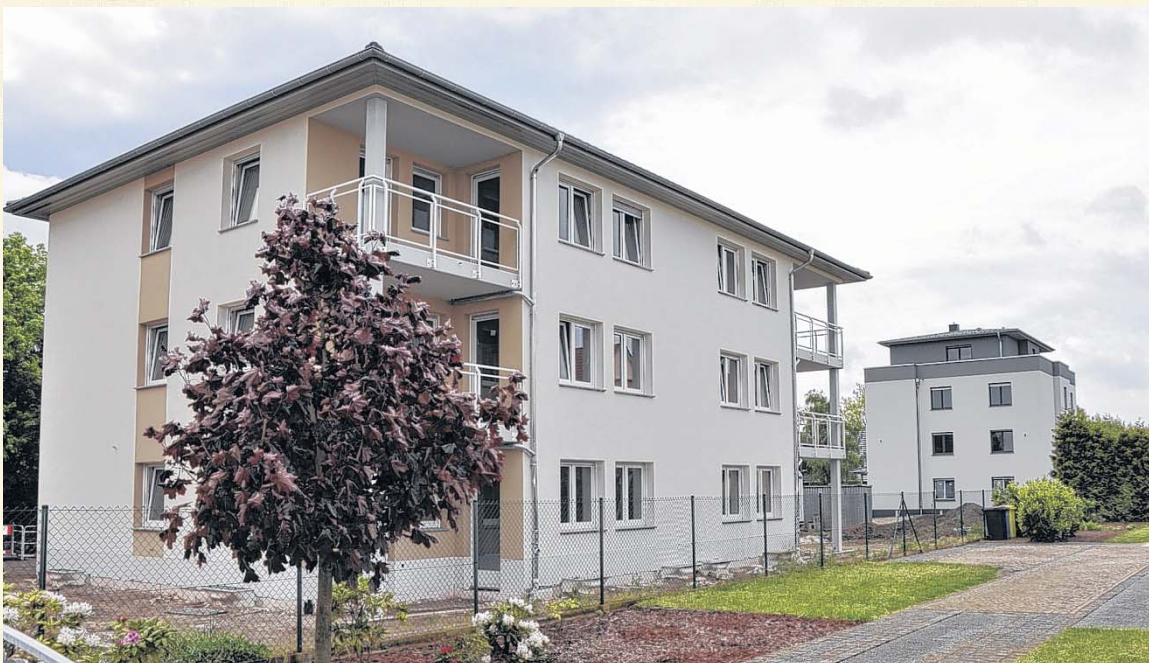
Blick von der Haferbreite: Die zwei neuen Mehrfamilienhäuser mit insgesamt zehn Wohnungen.
