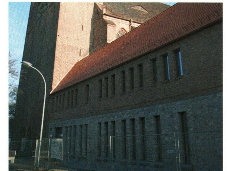
Gemein hat der neue Westflügel mit dem historischen Vorbild nur Baumaterialien aus Ziegel- und Naturstein sowie die alten Grundmauern, die noch brauchbar waren. Fotos (2): Marina Wienecke
